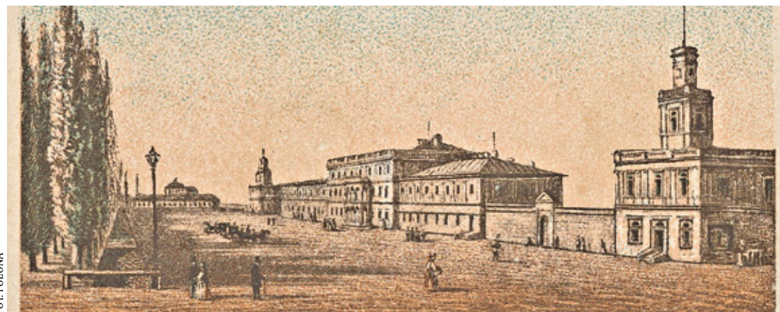
Dworzec w Warszawie kolei Warszawsko-Wiedeńskiej przed 1900 r.
