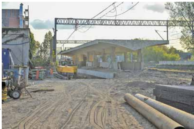
Po 24 września kontynuowane będą prace wykończeniowe na stacji w Pruszkowie
