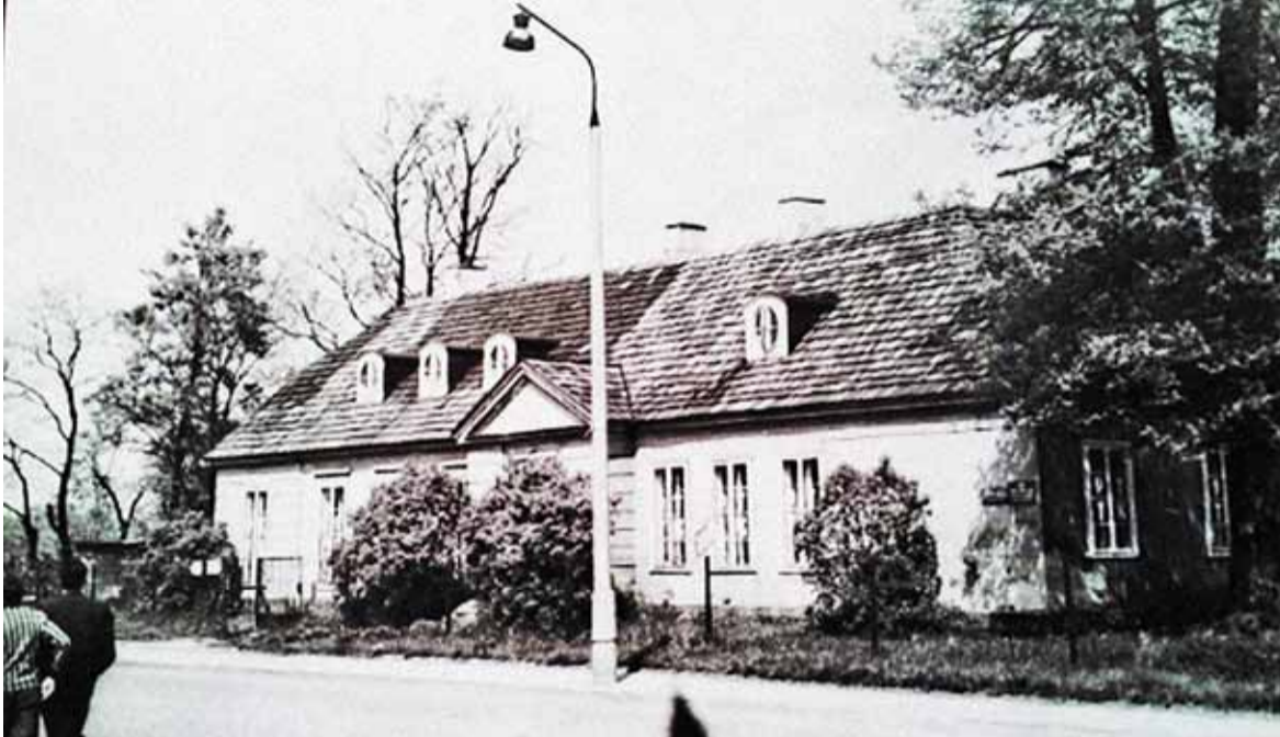
Dwór w Jordanowicach przed remontem – Grodzisk Mazowiecki
