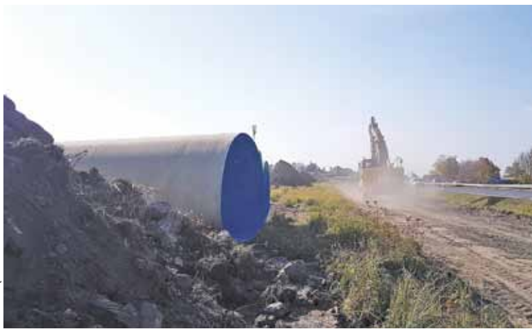
Roboty prowadzone są wzdłuż Al. Jerozolimskich
