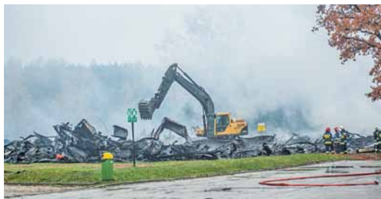
Konstrukcja hali zawaliła się do środka
