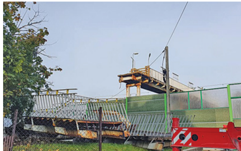
Stara kładka została już zdemontowana
