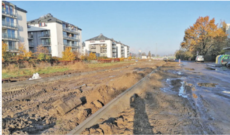
Budowa ul. Działkowej
