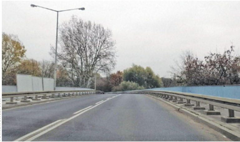
Wiadukt w ciągu DW 718
