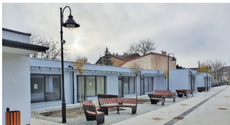
Stare pawilony handlowe zastąpiono nowymi, pojawiła się również mała architektura
