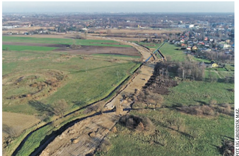
Prace ruszyły późną jesienią ubiegłego roku
