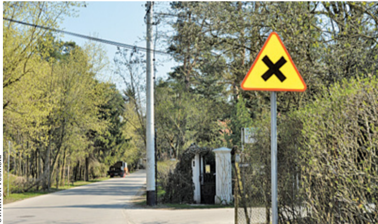
Proponowane zmiany mają na celu poprawę bezpieczeństwa wszystkich użytkowników dróg
