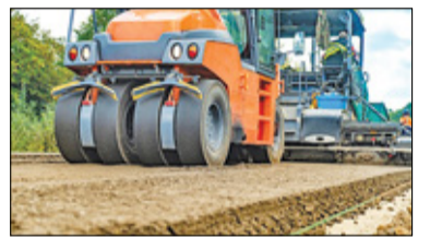
Pruszków - Krok w stronę budowy s. 5
