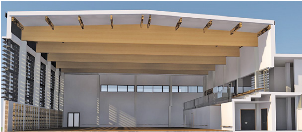
FOT. MAŁGORZATA PACHECKA W połowie przyszłego roku inwestycja ma być gotowa
