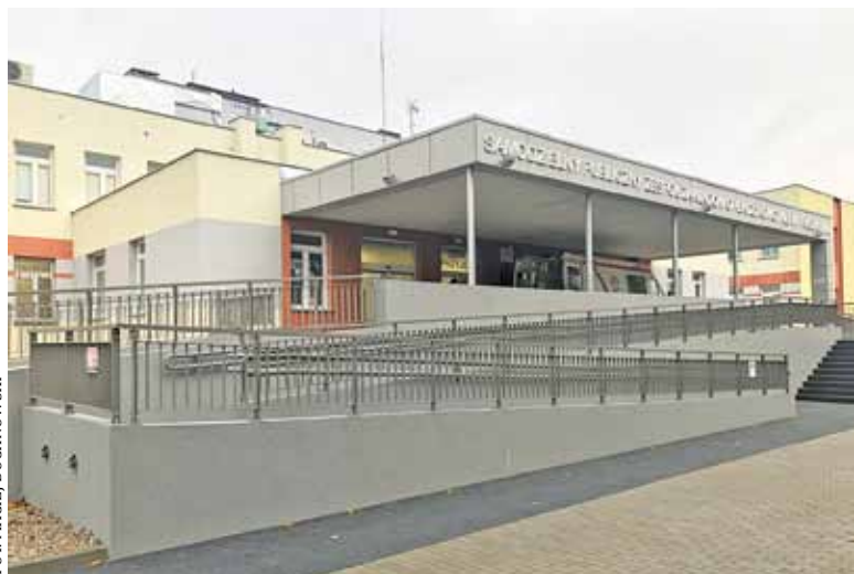
Szpital powiatowy na Wrzesinie
