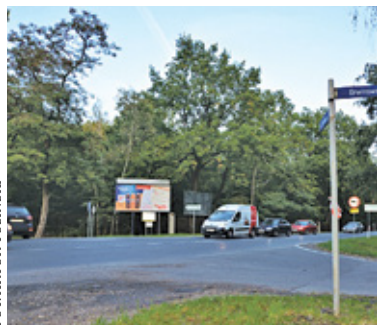
Samorzady pracują już wspólnie nad przebudową skrzyżowania na styku trzech gmin
