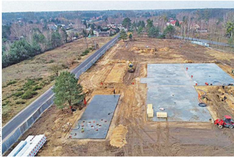
Wykonawca wylał już betonowe posadzki pod baseny
