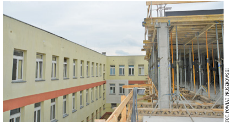
W ubiegłym roku ruszyła rozbudowa szpitala
