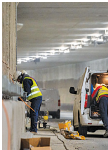
W tunelu trwają prace nad ułożeniem betonowej nawierzchni i okładzin ścian
