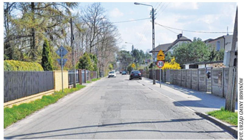
Niektóre inwestycje – jak remont ul. Kępińskiej – już są na początkowych etapach realizacji
