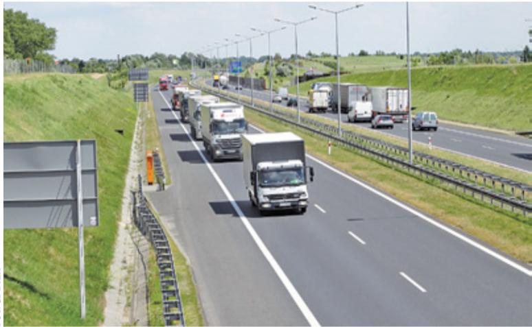
Na razie drogowcy zajmą się budową odcinka od granicy woj. mazowieckiego do węzła Łódź Północ
