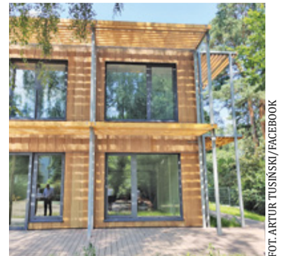
Budynek przedszkola powstał metodą modułową
