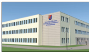
||| Pruszków - Problemy na budowie s. 4
