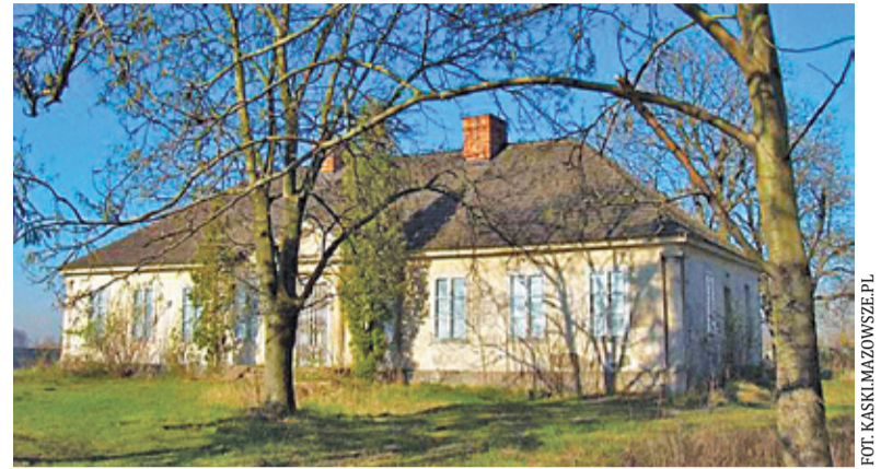
Dworek ma zyskać m.in. nowe pokrycie dachowe oraz stolarkę drzwiową i okienną
