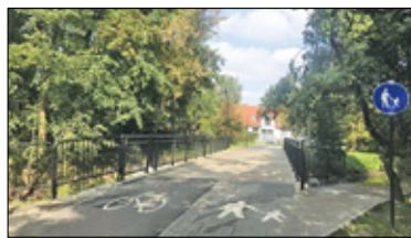
||| Pruszków - Mostek nad Utratą gotowy s. 2
