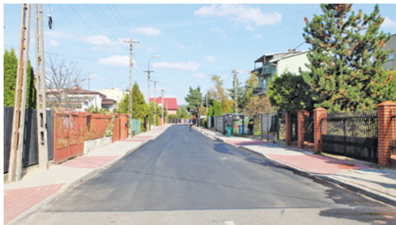
W ramach inwestycji położono między innymi nową nawierzchnię i wybudowano chodniki
