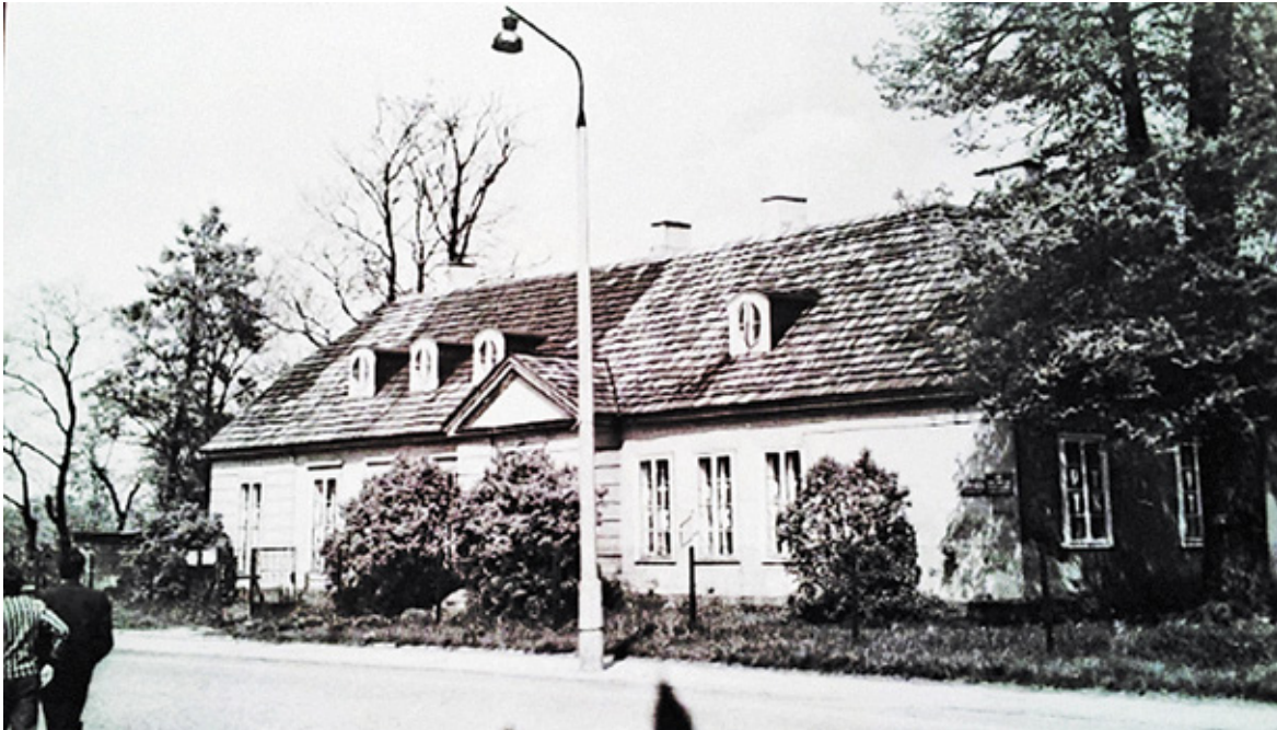
Dwór w Jordanowicach przed remontem – Grodzisk Mazowiecki
