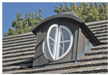
Fragment dachu z lukarną na budynku dworku w Jordanowicach
