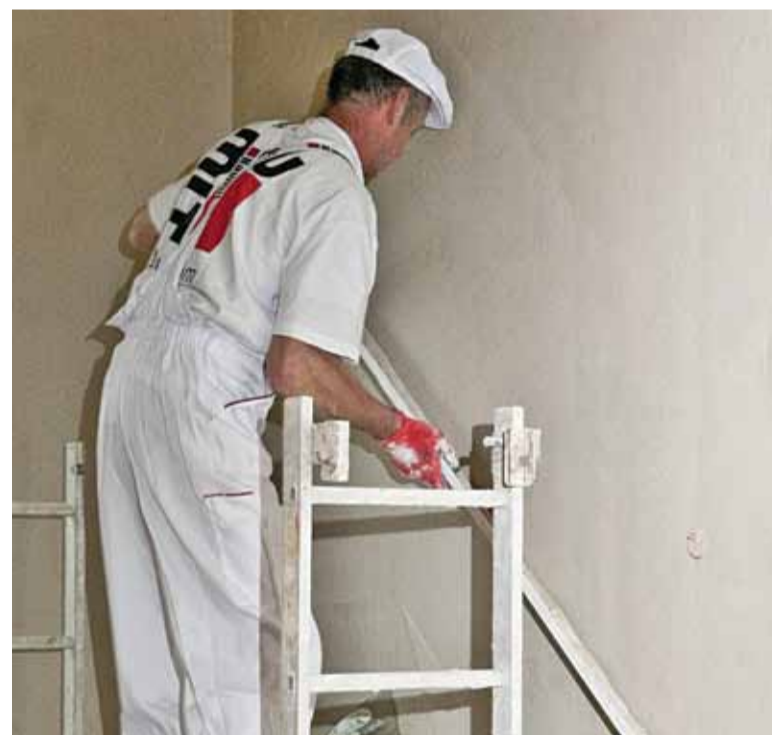
Wyrównywanie tynku łatą trapezową
