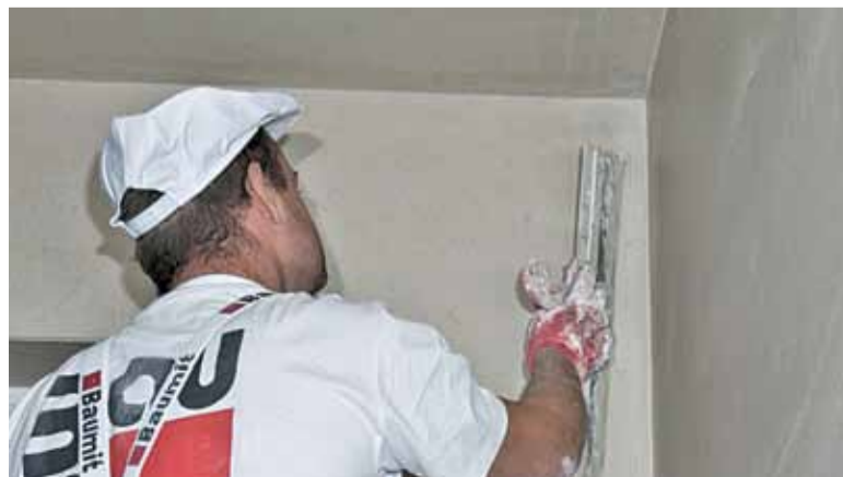
Wygładzanie tynku szpachlą metalową
