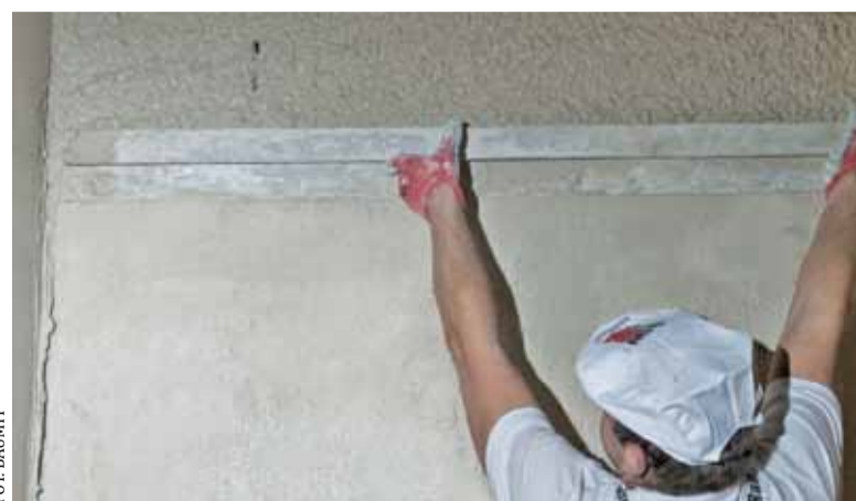
Rozprowadzanie narzuconego tynku łatą tynkarską
