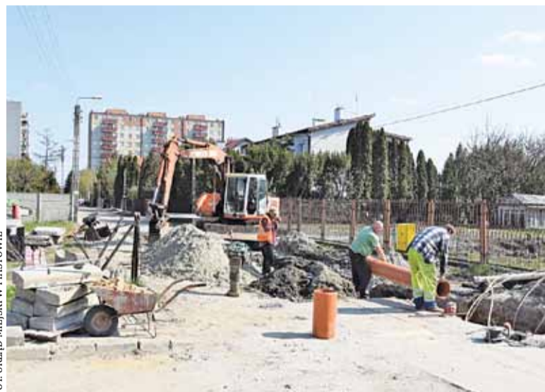
Miasto w latach 2016-2018 wybudowało ponad 5 km przewodów wodociągowych
