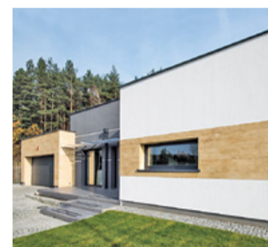
Motyw drewna można bez trudu uzyskać przy użyciu tynku modelowanego
