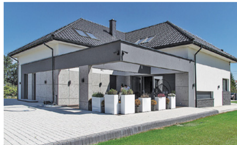
Efekt betonu uzyskany dzięki zastosowaniu tynku modelowanego Baumit CreativTop
