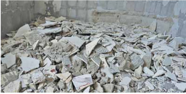
PSZOKi przyjmują elementy poremontowe
