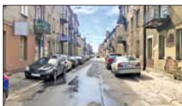
Pruszków – Przebudowa Stalowej s. 4
