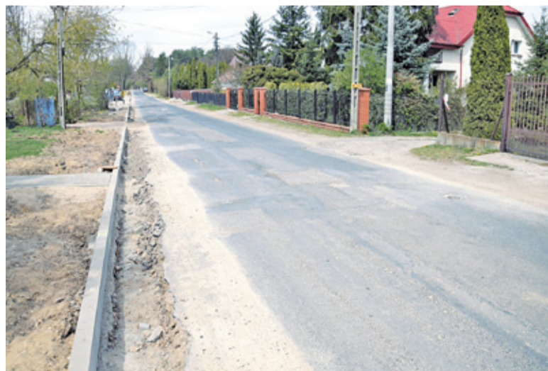
Na przebudowywanej ulicy konieczne będzie uspokojenie ruchu
