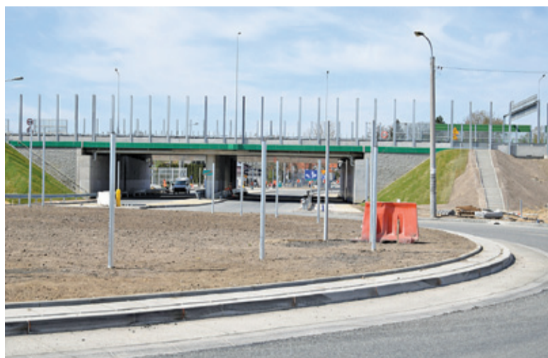
Węzeł Nadarzyn był przejezdny już przed świętami
