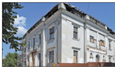
||| Brwinów - Remont pałacu nabrał tempa s. 3
