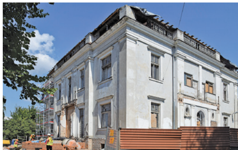
Prace przy renowacji pałacu postępują w dobrym tempie
