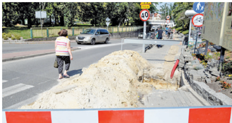
Wykonawca już rozpoczął prace
