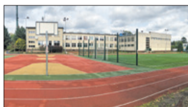
||| Michałowice - Przebudowa zaplecza sportowego s. 2
