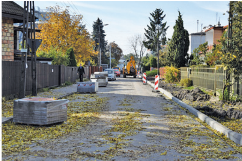
Na ul. Skargi trwają prace
