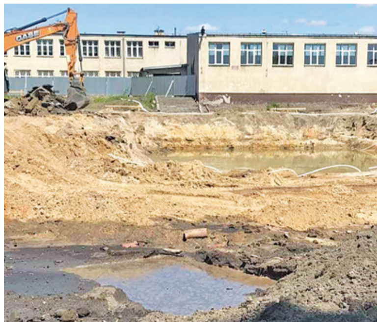
Trwa I etap inwestycji
