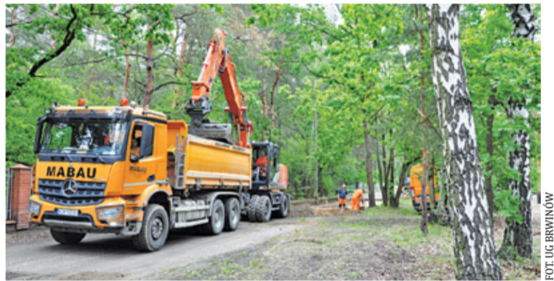
Robotnicy zakończyli już pomiary geodezyjne i rozpoczęli prace
