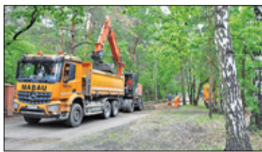
||| Brwinów – Remontują Milanowiecką s. 2
