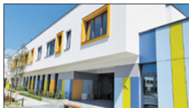
||| Pruszków - Obiekt zrealizowany kompleksowo s. 5
