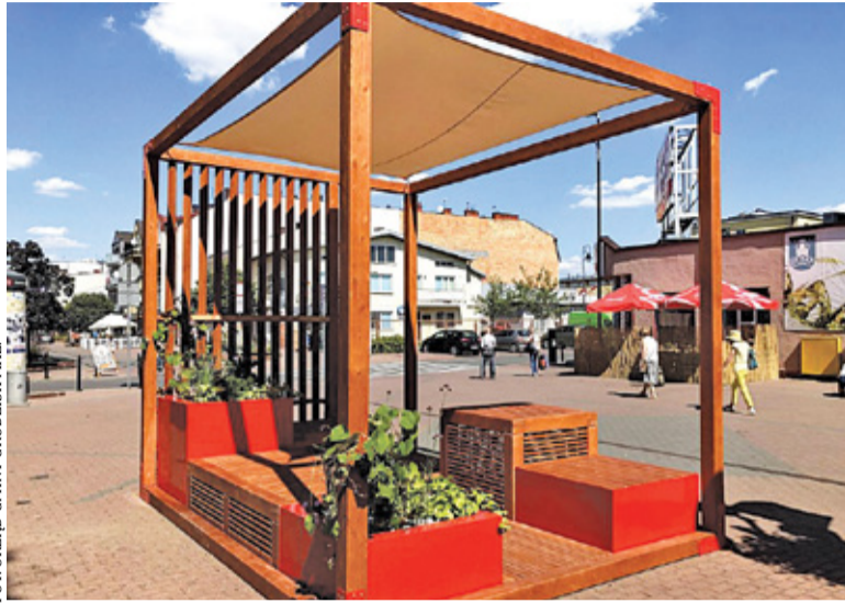
Konstrukcja parkletów jest modułowa, co pozwala na ich demontaż i przeniesienie w inne miejsce
