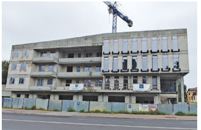
Budynek przy al. Armii Krajowej 46
